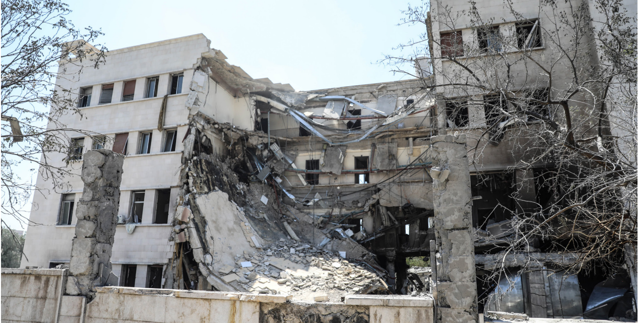
Görsel 5. İsrail hava saldırısında vurulan Suriye Genelkurmay Başkanlığı binası
